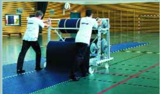
Colocación del revestimiento con el expositor DPP
