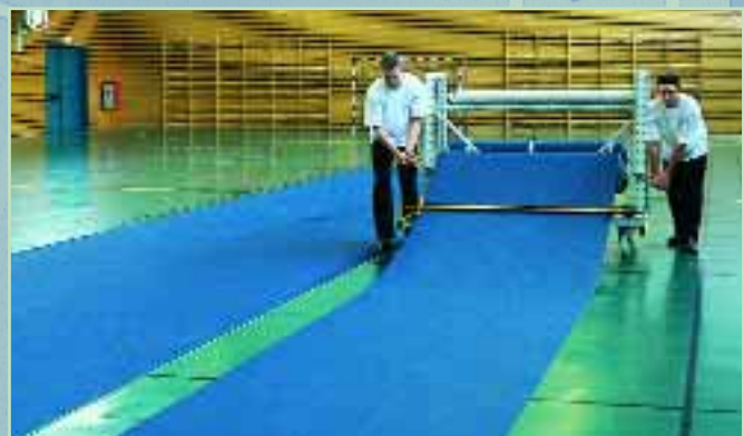
Enrollamiento del revestimiento con el expositor equipado del kit de guiado
