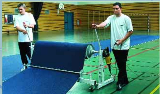
Enrollamiento motorizado del revestimiento con el aparato de transporte
